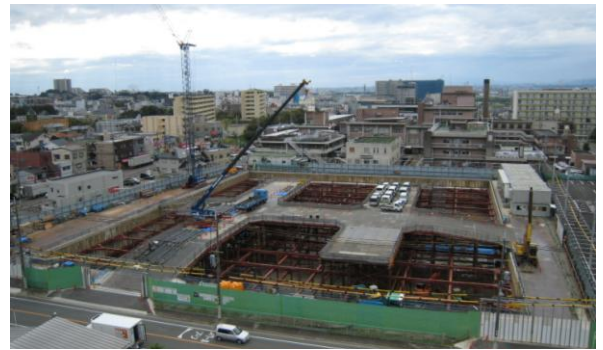
(平成 24 年 10 月 免震層躯体工事中)
