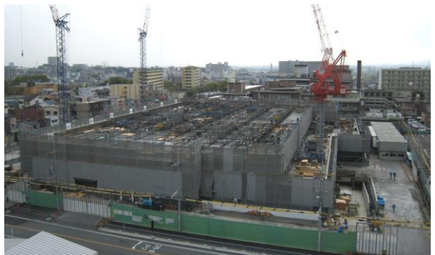
(平成 25 年 4 月 2 階部分躯体工事中)
