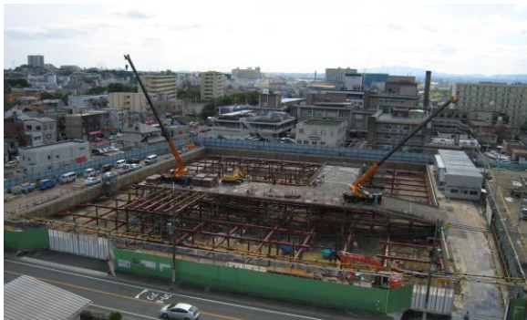
(平成 24 年 6 月 掘削工事中)
