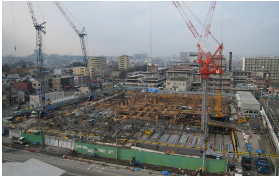
(平成 25 年 2 月 地階部分躯体工事中)
