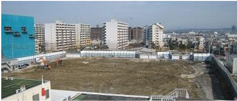
(平成 24 年 3 月 掘削工事着手前)
